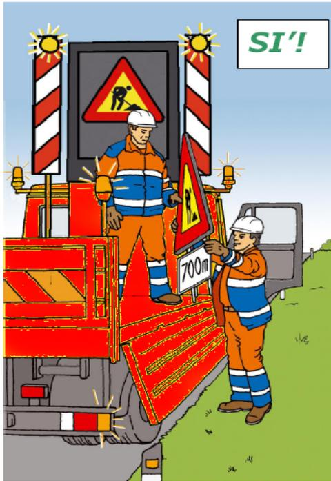
L'addetto o gli addetti, con segnale a cavalletto in mano, attraversano la carreggiata per posarlo nel punto indicato per la canalizzazione del traffico.
