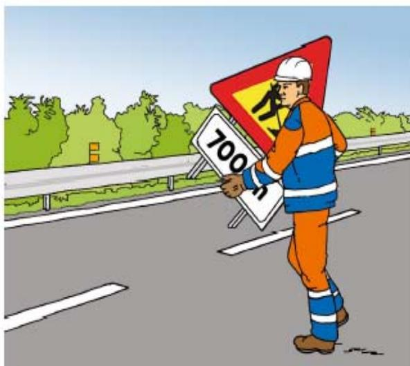
L'attraversamento, per portare i segnali in spartitraffico, deve essere effettuato tenendo i cartelli, la lanterna e/o i supporti sul lato destro del corpo al fine di evitare il possibile effetto vela; nell'operazione inversa i cartelli e gli altri dispositivi andranno tenuti sul lato sinistro del corpo.
