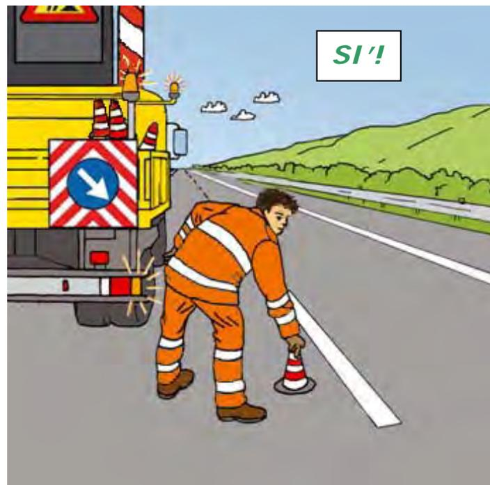
Figura 35 – Posizionamento dei coni o dei delineatori flessibili: comportamento corretto
