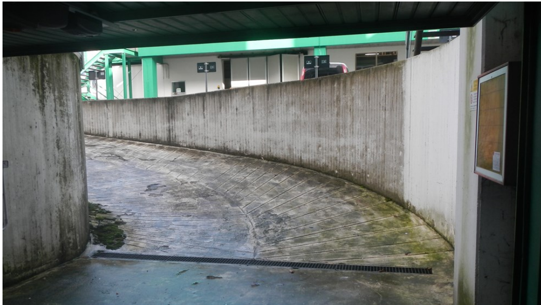
FIGURA 14 PARTICOLARE DELLA RAMPA DI ACCESSO AL PIANO DI CONSEGNA
