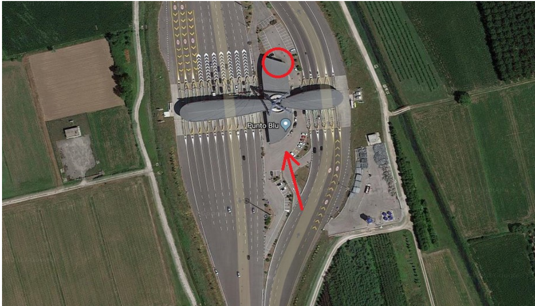
FIGURA 7 VISTA DALL'ALTO DEL SITO DI CONSEGNA DELLA FORNITURA, LA POSIZIONE DEL LOCALE È INDIVIDUATA DAL CERCHIO ROSSO E LA VIA DI ACCESSO AL SITO TRAMITE VIABILITÀ ESTERNA È INDIVIDUATA DALLA FRECCIA ROSSA
