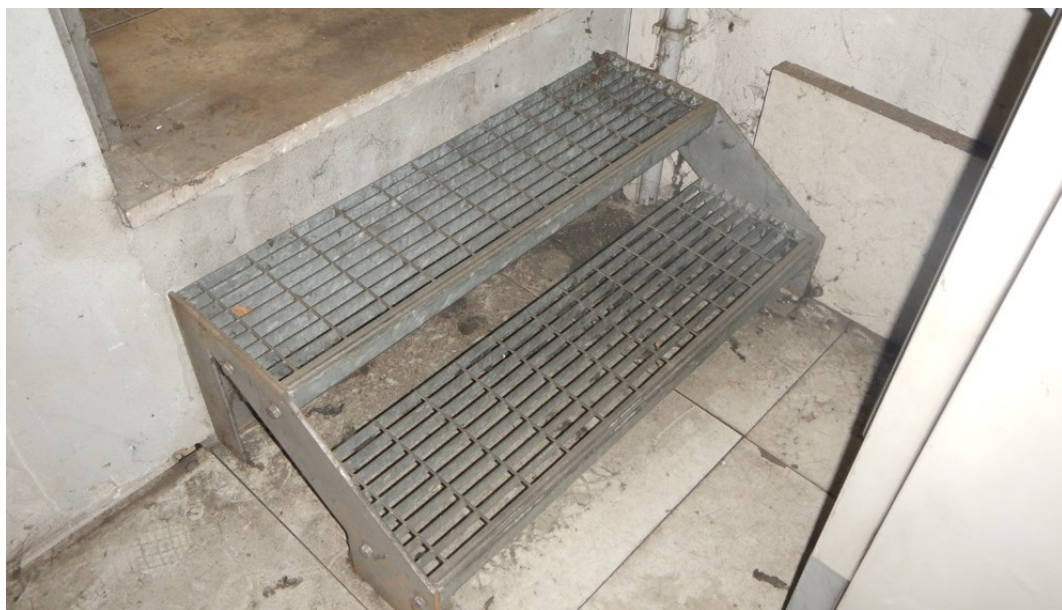
FIGURA 4 PARTICOLARE DEL DISLIVELLO INTERNO AL LOCALE DI CONSEGNA.
