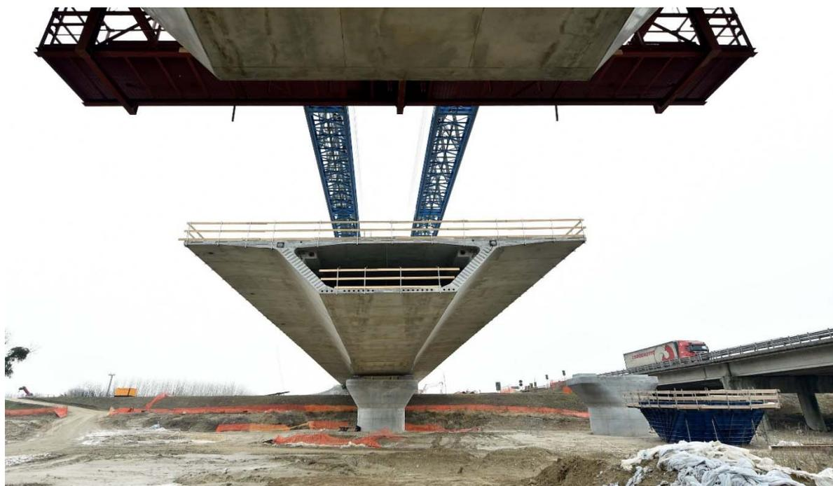
**Assemblaggio dei conci del primo viadotto del ponte sul fiume Tagliamento**
