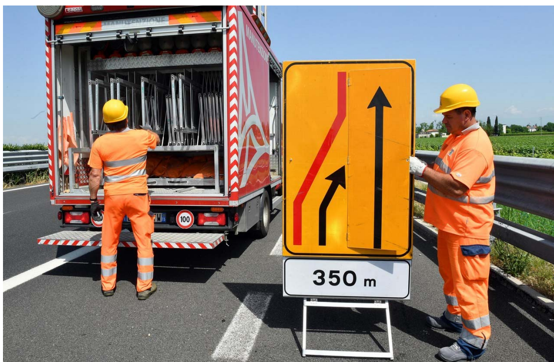
Attività di manutenzione lungo la A4
