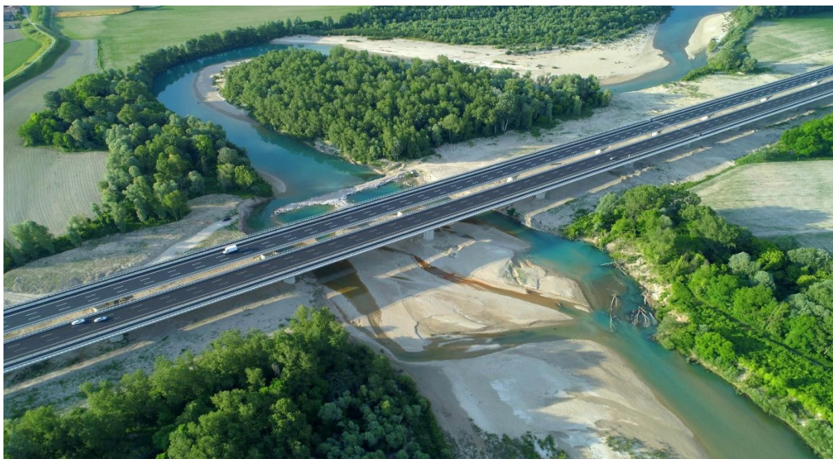
Il nuovo ponte sul fiume Tagliamento
