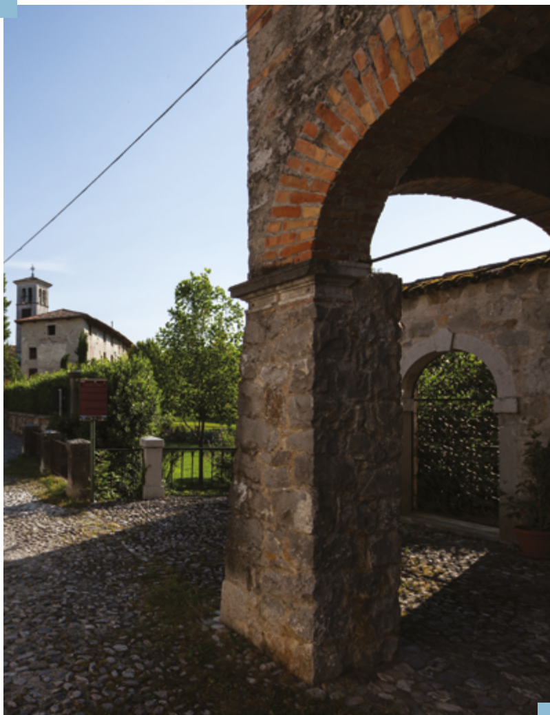
[BORGO DI STRASSOLDÒ. CASTELLO DI SOPRA]
